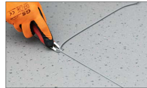
1. Procédure avec araseur MOZART avec guide d'arasement.
